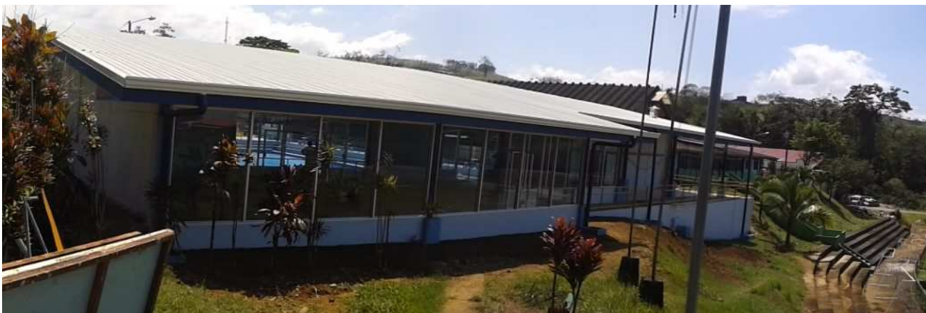
Ilustración 23. Vista panorámica del edificio.
