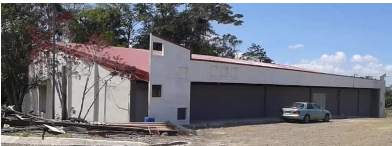
Ilustración 19 y 20. Proceso de pintura en exteriores.
