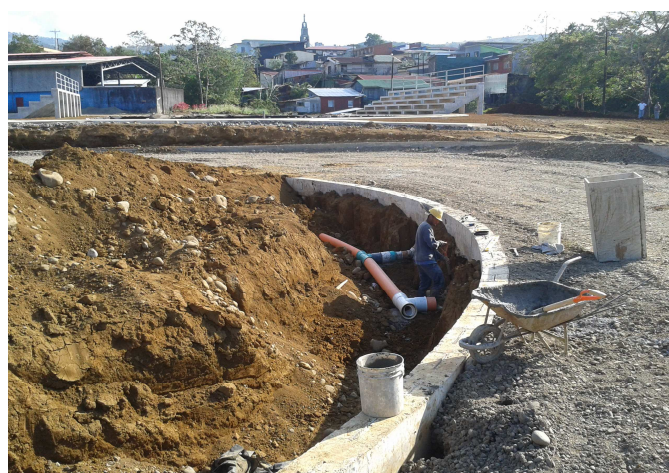
Ilustración 24 y 25. Construcción de Cajas de Registro y tuberías de evacuación pluvial hasta el rio. Así como construcción del sistema de evacuación pluvial interno de la pista de patinaje.
