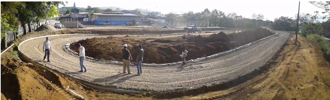
Ilustración 26. Vista panorámica de avance en la estructura de pavimento, confinada por los bordillos y cuneta especial en concreto.
