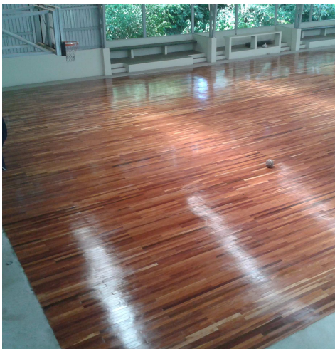
Ilustración 17 y 18. Proceso aplicación producto poliuretano en capas.
