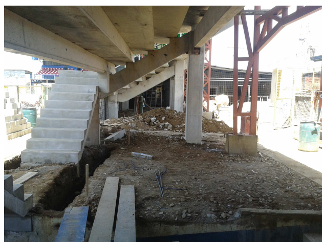
Ilustración 33 y 34. Estructura de Gradería prefabricada totalmente instalada en sitio, así como acceso a la misma.
