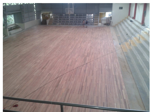
Ilustración 13 y 14. Proceso de Lijado del piso de madera tipo tabloncillos
