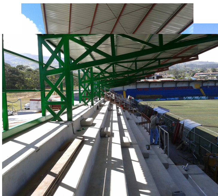
Ilustración 33 y 34. Estructura de Gradería prefabricada totalmente instalada en sitio, así como acceso a la misma.
