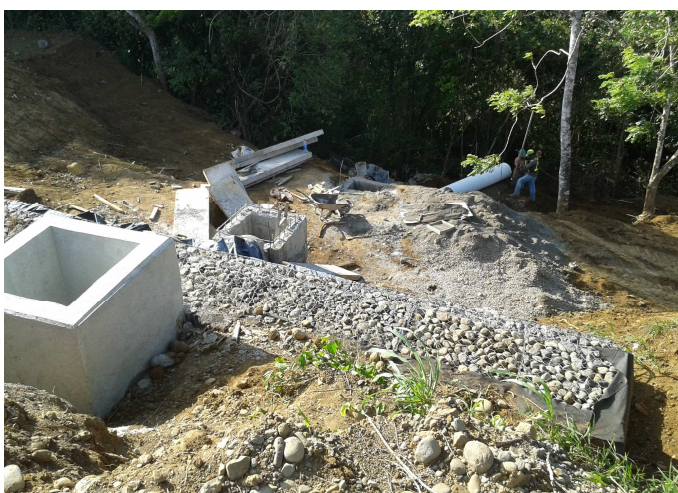
Ilustración 24 y 25. Construcción de Cajas de Registro y tuberías de evacuación pluvial hasta el rio. Así como construcción del sistema de evacuación pluvial interno de la pista de patinaje.
