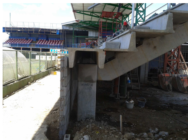
Ilustración 33 y 34. Estructura de Gradería prefabricada totalmente instalada en sitio, así como acceso a la misma.
