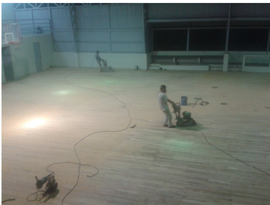
Ilustración 13 y 14. Proceso de Lijado del piso de madera tipo tabloncillos
